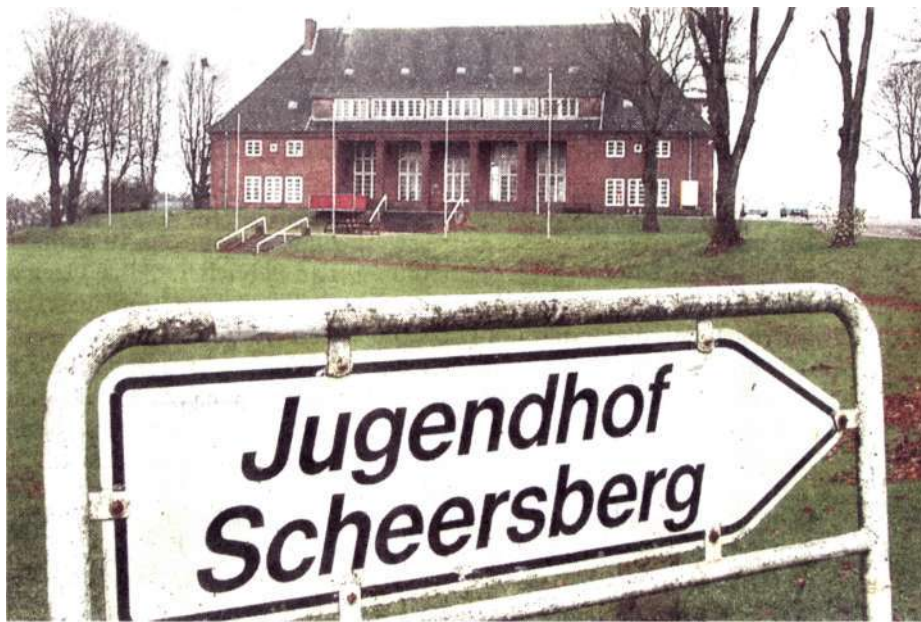
Das betagte Wallrothaus soll in diesem Jahr mit finanzieller Hilfe des Kreises, der Umlandgemeinden und der Aktivregion „Schlei-Ostsee“ endlich saniert werden. SH:Z
